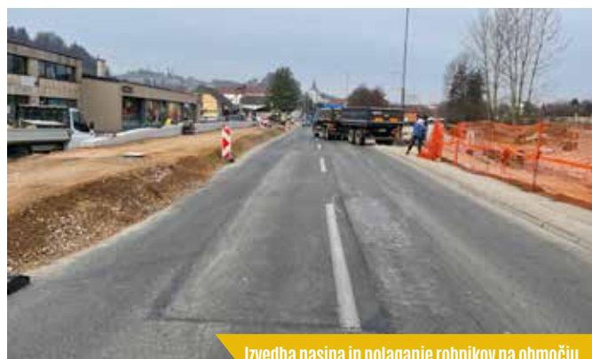
Izvedba nasipa in polaganje robnikov na območju pločnika. Foto: arhiv občine
