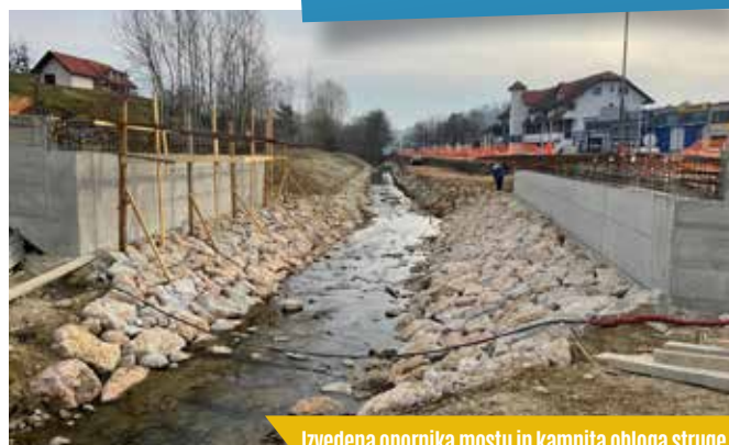
Izvedena opornika mostu in kamnita obloga struge potoka. Foto: arhiv občine
